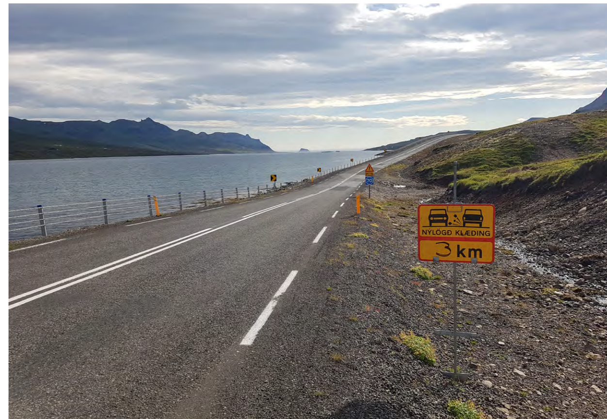
Hringvegur (1). Vinnusvæðamerking á Sævarendaströnd í Fáskrúðfirði.
