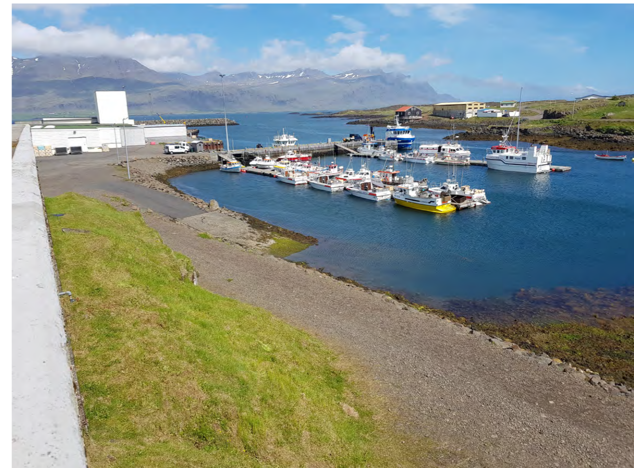
Höfnin á Djúpavogi en unnið er að endurbyggingu stálþils.
