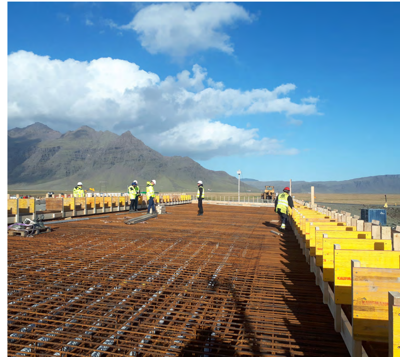
Frá byggingu brúar yfir Steinavötn.
