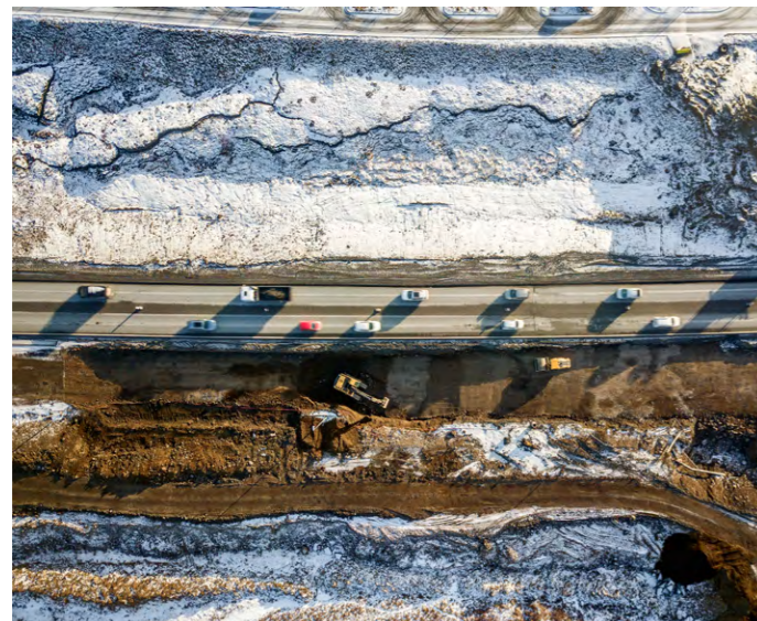
Framkvæmdir við Reykjanesbraut (41) í Hafnarfirði. Mynd: Baldur Kristjánsson
