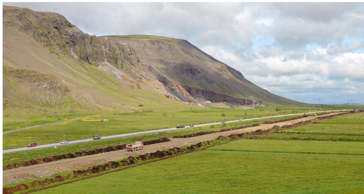
↑ Unnið að öðrum áfanga breikkunar Suðurlandsvegur (1) milli Biskupstungnabrautar og Gljúfurholtsár.
