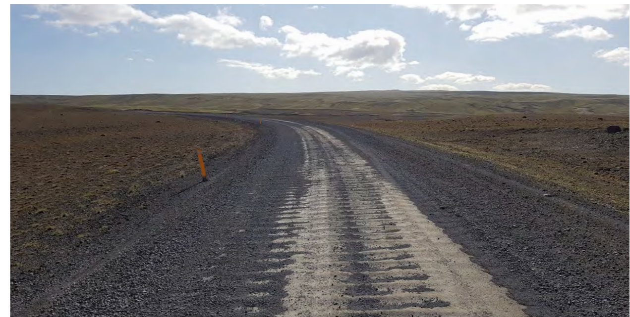
↓ Laugarvatnshellavegur (367). Þvottabretti á malarvegi milli Lyngdalsheiðarvegur og Laugarvatnshella.
