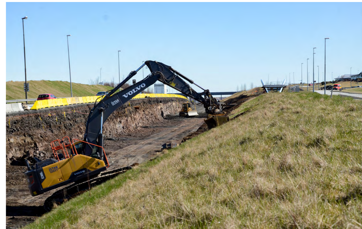
↑ Reykjanesbraut (41) framkvæmdir við tvöföldun milli Kaldárselsveggar og Krýsuvíkurvegar (2).
